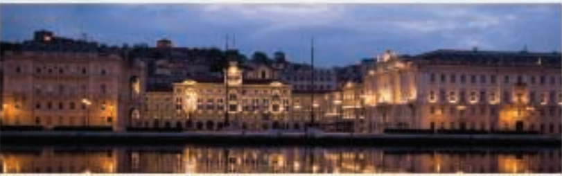
Il palazzo del Comune di Trieste, opera dell'architetto Bossi, risalente al 1878
